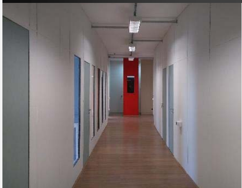
Reforma Elétrica PRPG
