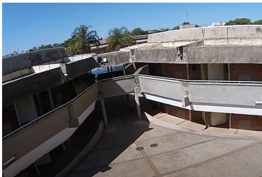
Figura 1: Prédio do Ciclo Básico
